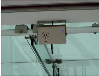
出入口に設置された音響案内のスピーカーの例。建物へ到着したことを音で示す。
