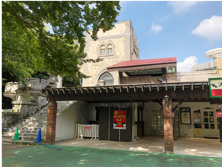
としまえん閉園直前の「古城の塔」（令和2年）。外壁は何度も補修されてきました
