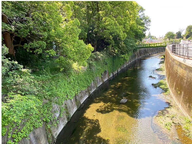
としまえん跡地の中央を東西に流れる石神井川。川の北側にあった遊園地エリアが、現在はスタジオツアー東京になっています
