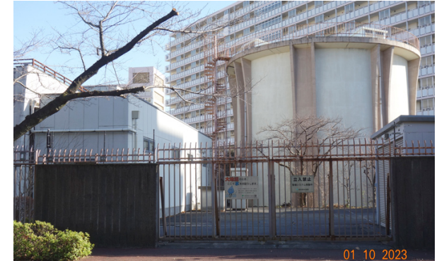
01_10_2023 光が丘にあるこのタンク、どんな仕組みになっているのでしょうか？
