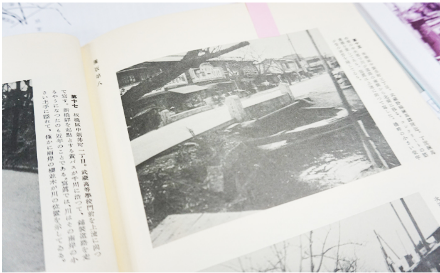
橋は取り壊されていますが、この親柱は 今も現場に残されています（復元）
