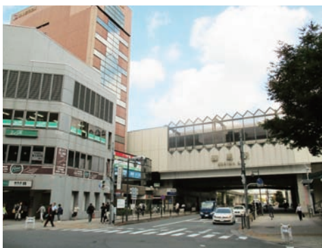
千川通りから見る練馬駅
