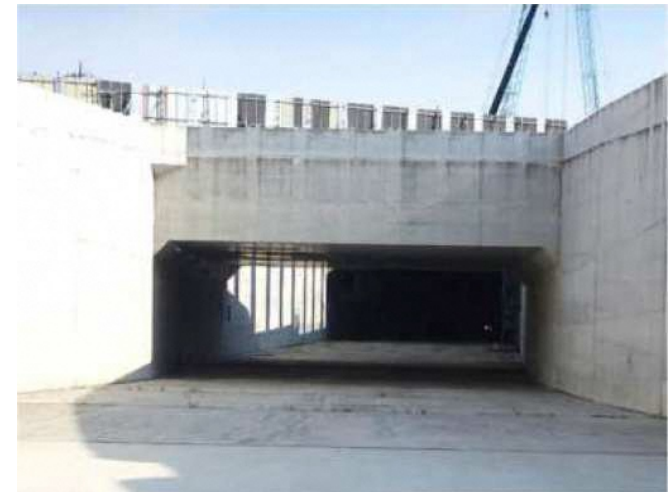
写真② (ボックスカルバート構造)
