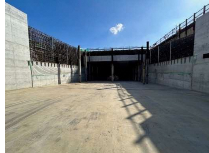
写真① (U型擁壁構造)
