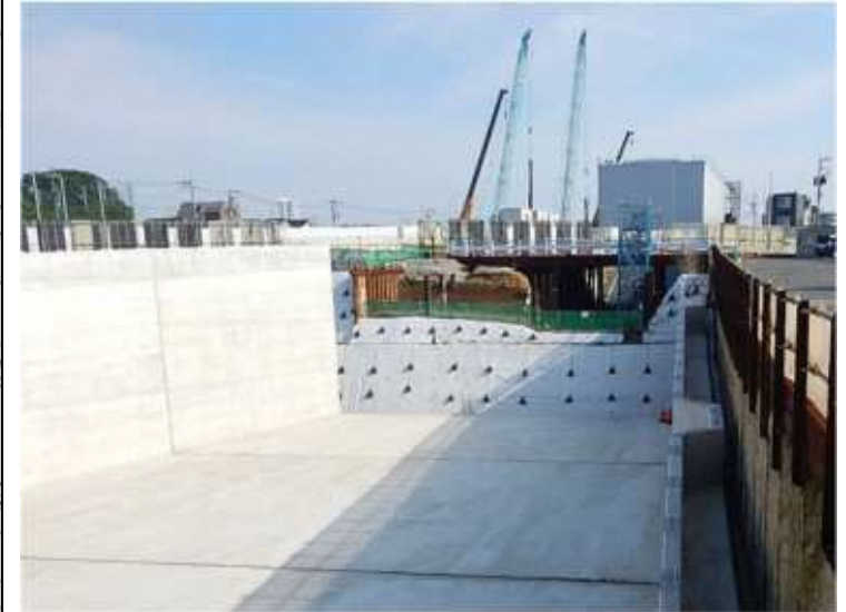
写真①(U型擁壁構造)
