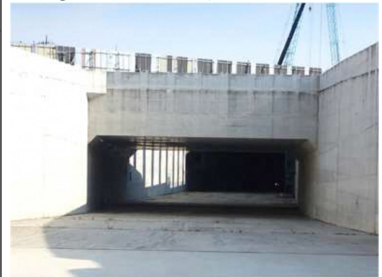
写真②(ボックスカルバート構造)
