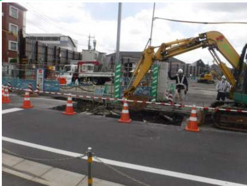
ライフライン(水道管等)防護ための コンクリート板設置工事(写真は街渠撤去状況)(R4.9月)
