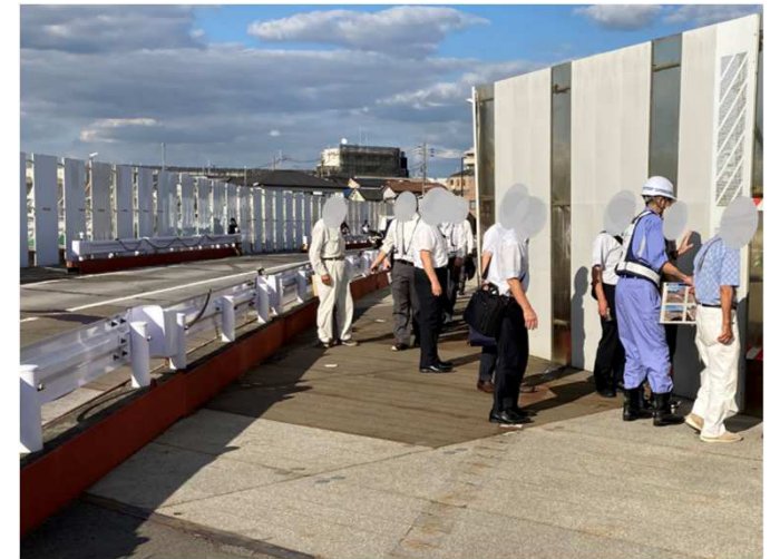
現地確認の様子(東映通り)
