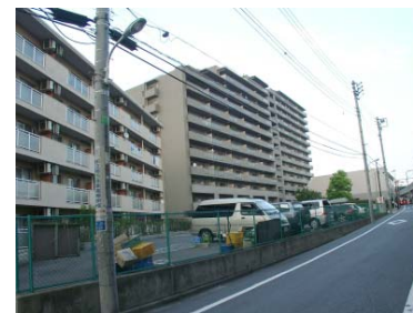
駅周辺の高層住宅
