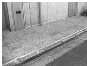
○壁面後退部分を歩道状に整備した事例
