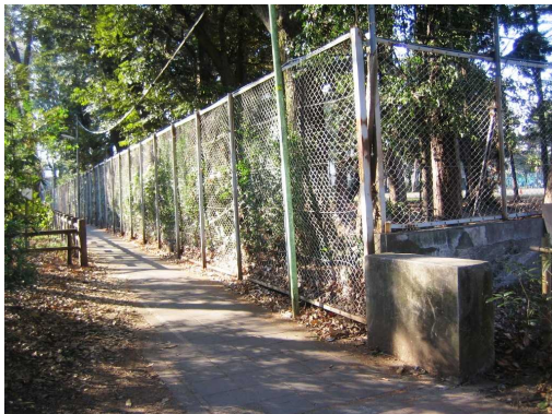
現況写真：南側区道南東の角
