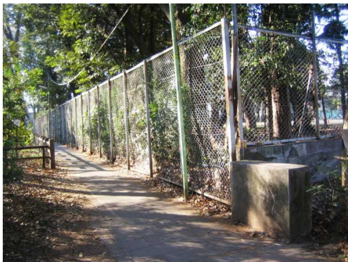
現況写真：南側区道南東の角
