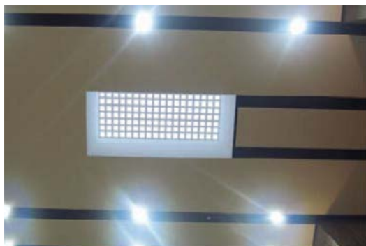
写真) スクールラウンジの上部にトップライトを 設け、昼間の電気消費を削減
