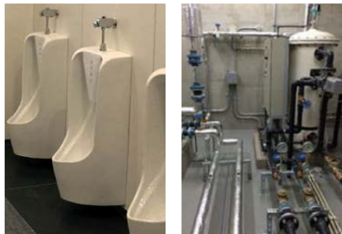
校舎に降る雨水をトイレ等の水として再利用
