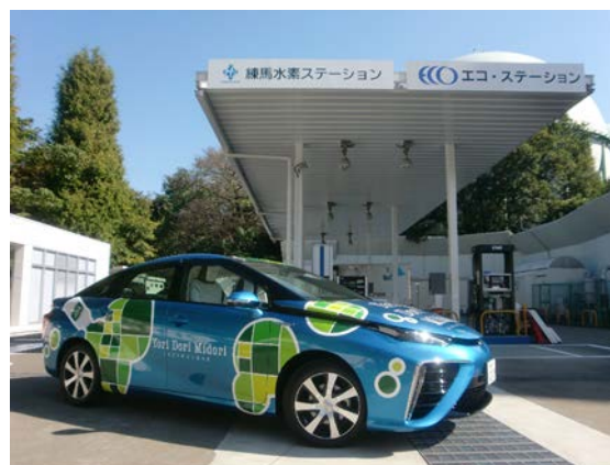
写真) 練馬区谷原に開設された水素ステーション
