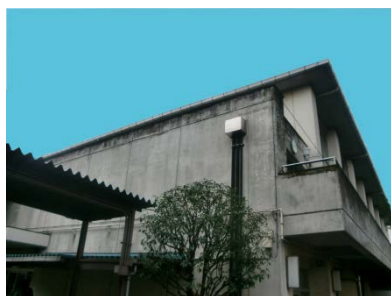
練馬区立南町小学校 体育館棟
