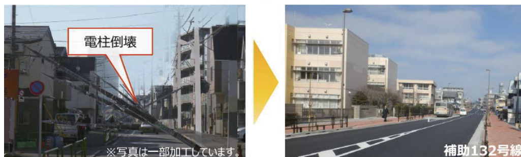
電柱が多い道路では地震等による倒壊の危険性が高い
