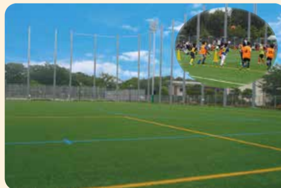
夜間照明付き人工芝グラウンド
