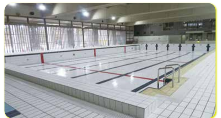
タイル交換をしたプール
